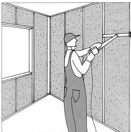
Рис. 96 а и б Нагнетание изоляционного материала и выравнивание поверхности.
