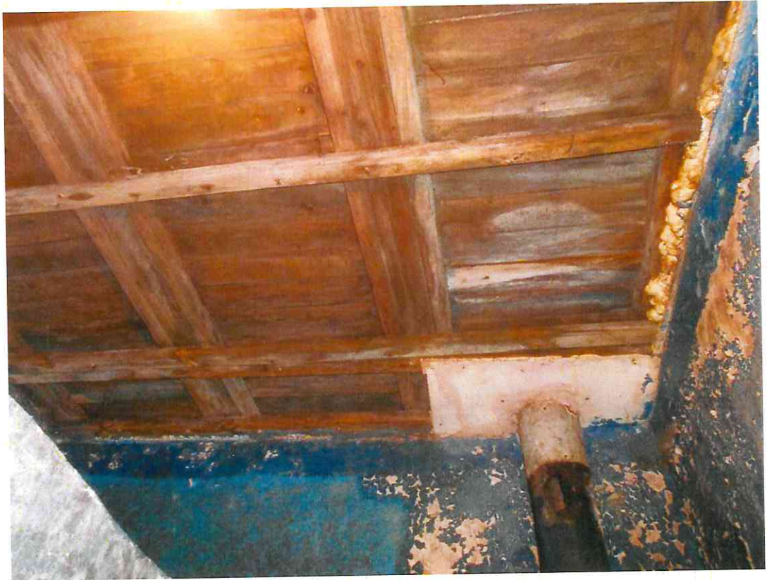
Фото 22. Ремонт деревянного перекрытия
